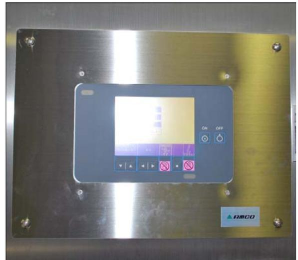
① 既存の情報パネルの中に、コントロールパネルを埋め込むことにより表面パネルは平になりました。トランス部分は収納ボックスに納めました。
