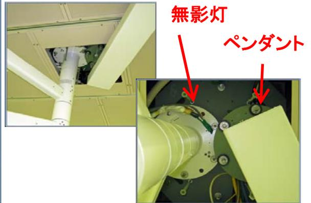
⑥ マッケ2000のチューブ外径太さは $\phi 125\text{mm}$ で、ステリス製585のチューブ内径が $\phi 126.6\text{mm}$ 。マッケチューブにステリスチューブを差し設置は簡単に終了。もちろん、ペンダントを吊り降ろすことはありません。
