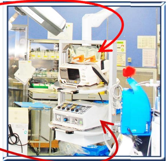
① 蘇生器と電メス両方を、ステリス用モニターアームに搭載するため、テーブルハンガーを製作しました。これはまるでシーリングペンダント！
